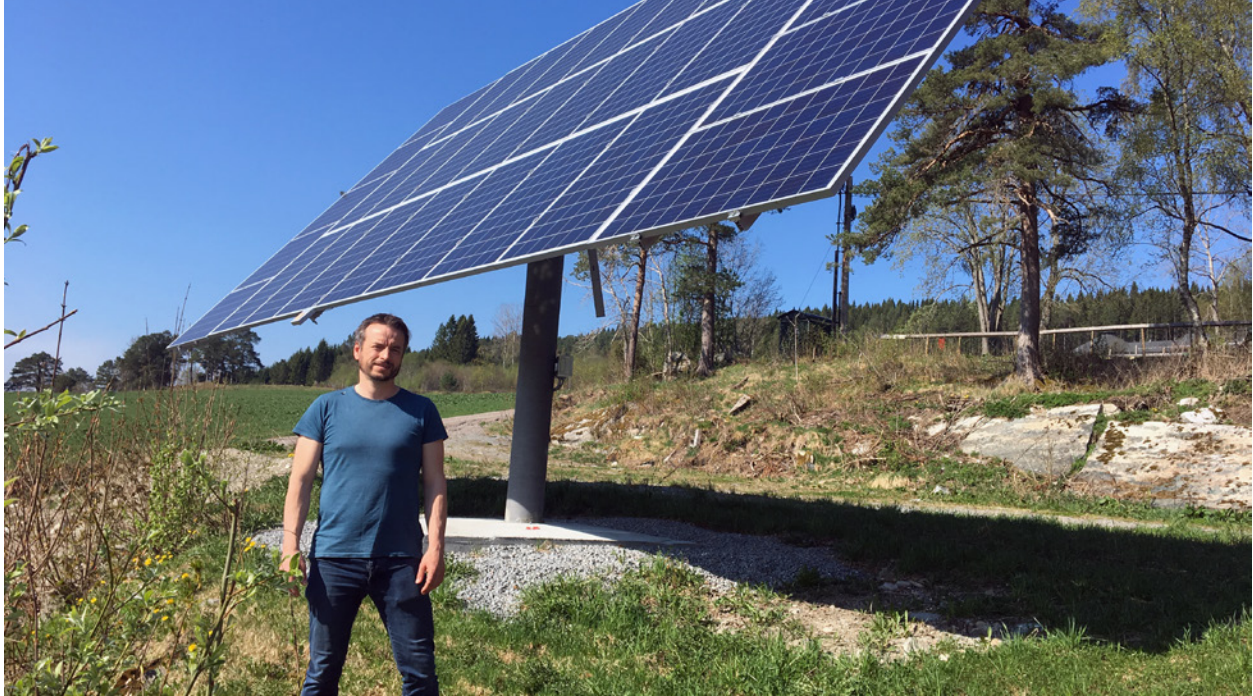
Ingvar Kvande foran det tracker-baserte solcelle-anlegget (9 kWp) på Tingvoll gard.
