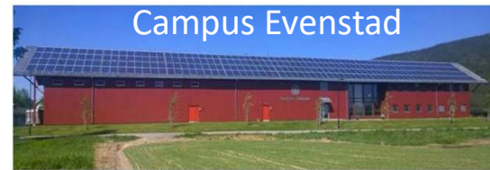
Solcelleanlegg på Evenstad. Foto: Thor Christian Tuv (Fusen AS)
